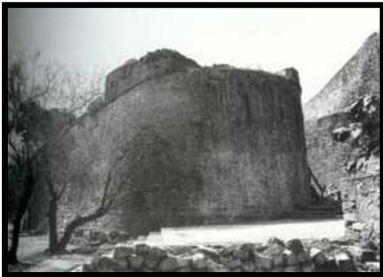
Bastion Tiepolo : le mur au front ouest. Nous remarquons la différence sur la construction entre la partie haute et la partie base (1ère phase de construction)
