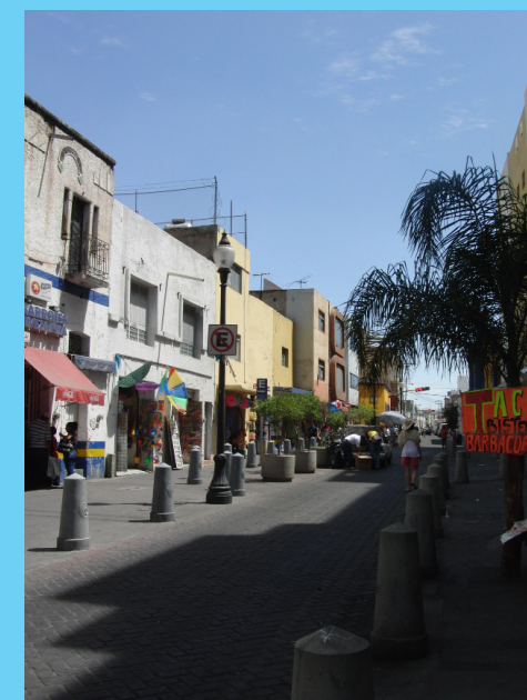
Photo n°12 Exemple d'enfouissement des réseaux dans le secteur Source : Atelier Mexique
