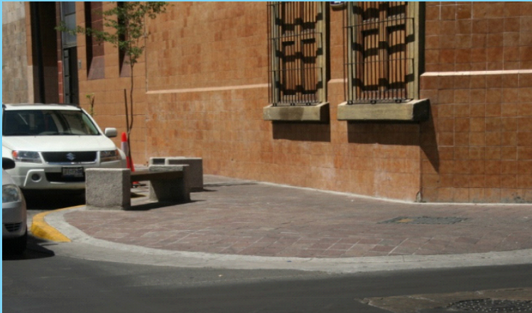
Photo n°7 Abaissement des trottoirs pour les personnes à mobilité réduite Source : Equipe Mexique
